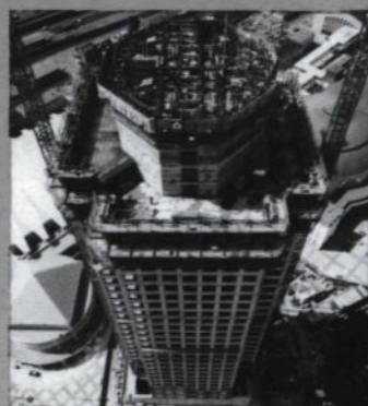
Die Gleitschalung für den Kern ist am weitesten fortgeschritten, die Kletterschalung für die Lochfassade folgt nach.
