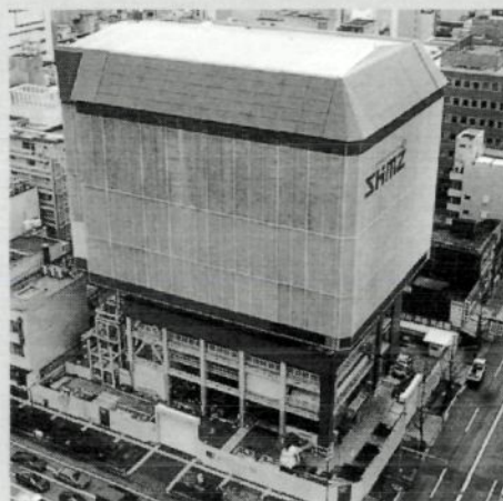
Oben: Konstruktionsablauf des 'SMART System' von Shimizu beim vollautomatischen Bau eines Hochhauses; links: Aufsicht auf die wetterfeste Arbeitsplattform; Mitte: Blick in das Kontrollbüro im Kopf des mobilen Arbeitsgeschosses
