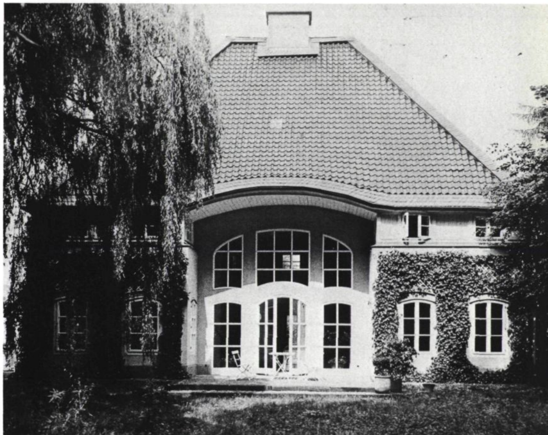
Rückansicht des Blauen Hauses vom Garten mit dem leicht ins Dach eingeschnittenen Fenster und der eingezogenen Loggia. Das hohe Walmdach ist mit glasierten Ziegeln gedeckt. First, Grate und Traufen sind mit Schiefer abgesetzt.
