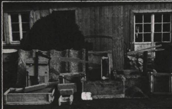
1. Mit der Gleitschalung werden Ofenrohre als Schalung für das Röhrensystem hochgeführt. Über und unterhalb der Wand befindet sich ein Querkanal, der alle Rohre miteinander verbindet. Durch das so entstehende Röhrensystem trocknet die Wand schneller aus.
