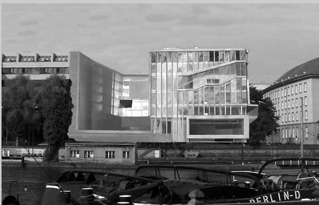
Die Aluminiumlochpaneelle sorgen im Wohntrakt für gute Belichtung bei gleichzeitigem Sichtschutz
