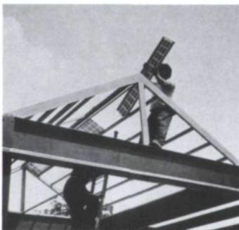
Während der Montage der Photovoltaikpaneele
