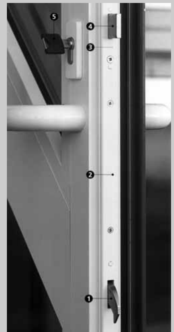
Links: Wilka-Zusatzschloß für Holzeingangstüren mit Profilzylinder; Oben: Mehrfachverriegelung mit drehbaren Schwenkriegeln in durchlaufender Schloßschiene
