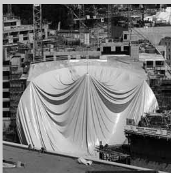
Luftbefüllungsvorgang der Kuppelmembrane, die später in Beton aufgespritzt wurde.
