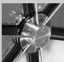
Kuppel des Weltbildverlags; ganz oben: Glashalterung und Rosette; oben: Blick Aufenthalts- und Empfangsbereich; rechts: Detail Rosette mit Isolierverglasung
