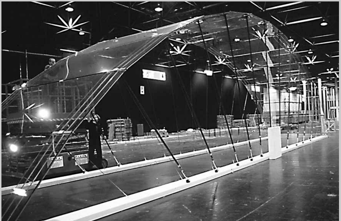
Der große Glasbogen, aufgebaut auf der glastech '98 in Düsseldorf; rechts oben: konstruktives Prinzip
