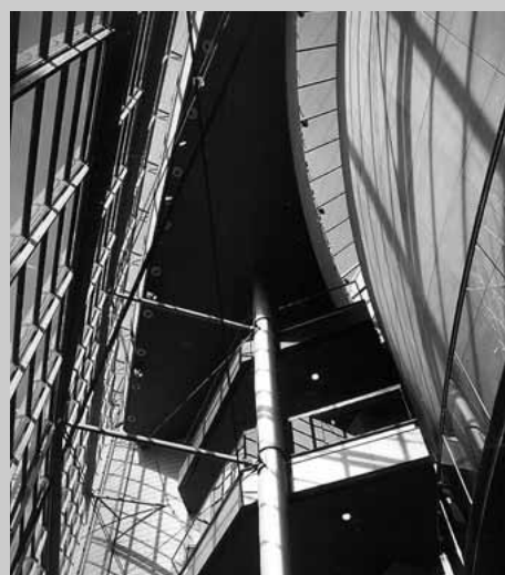
Fassadenkonstruktion der Vorführkuppel und seilverspannte Glas-Rundfassade aus 986 Aluminium-Glaselementen
