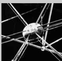
Detail Glashalterung mit Einfachverglasung
