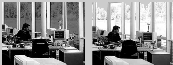
oben: Schichtenaufbau des elektrochromen Glases E-Control; darunter: E-Control im 'dunklen' Zustand, Lichttransmission 15 % (links), im 'hellen' Zustand, Lichttransmission 50 % (rechts); Diagramm: Versuche von Pilkington in zwei identischen Testzimmern – das eine mit normaler Isolierverglasung, das andere mit E-Control, ergeben: Aufgrund des höheren g-Wertes für elektrochromes Glas ist hier ein etwas höherer Heizenergiebedarf (Winter) vorhanden. Durch den wesentlich geringeren Kühlenergiebedarf (Sommer) wird jedoch insgesamt Energie eingespart.
