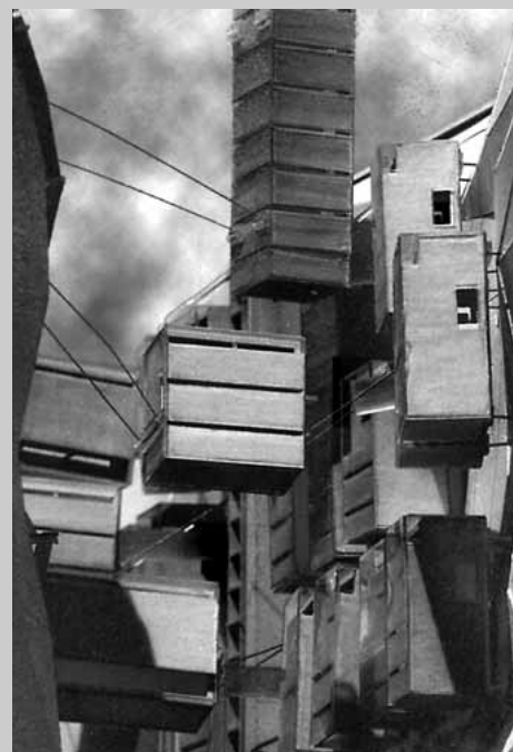
links: Vorgefertigte Module windgeschützt in Gletscherspalten. Abhängungen kompensieren die Bewegungen des Gletscherflusses.
