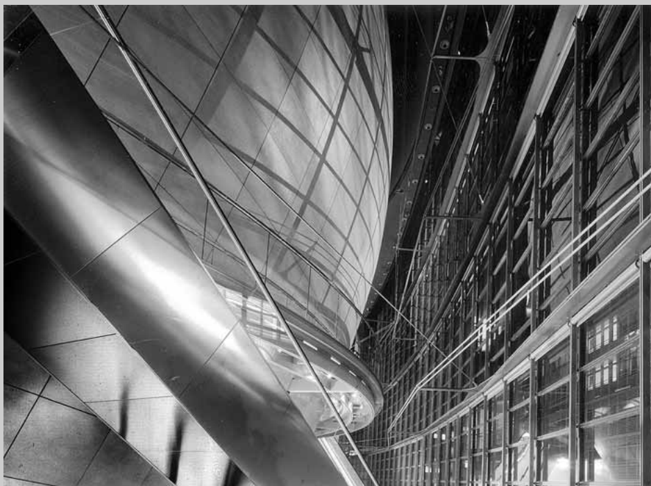
Fassadenkonstruktion der Vorführkuppel und seilverspannte Glas-Rundfassade aus 986 Aluminium-Glaselementen
