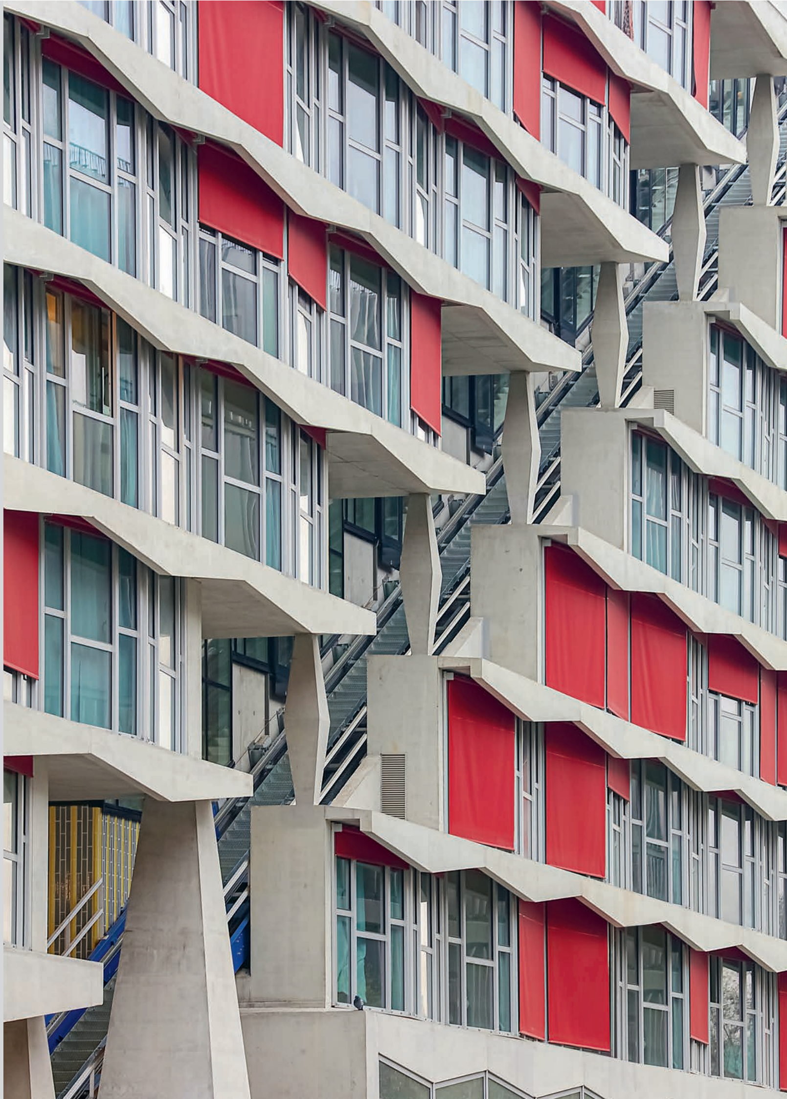
Ostfassade mit heruntergeklappten Brüstungen in Form gezackter Bänder, die der Dreiecksgeometrie der angewinkelten Fensterfassaden folgen. Die Bänder dienen dem Brandschutz und sollen den Brandüberschlag zwischen den Geschossen verhindern.
