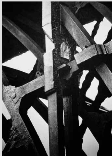
Gußeisen, detailliert wie Holz, Coalbrookdale Brücke.
