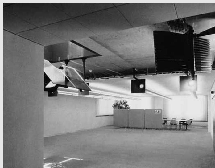
Helios-Versuchsanlage bei Regent, Basel; oben: kombinierte Kunst-/Tageslichtleuchte, Zwillingsrohr mit sensor-gesteuerter Leuchtstofflampe bestückt, Mitte: Sonneneinführung mit Hilfe eines der Sonne nachgeführten Heliostaten- und eines Umlenkspiegels, unten: über Konzentratoren wird das Tageslicht in die Leuchten geleitet.
