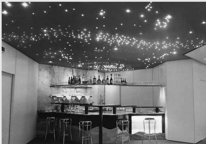
Einsatz von LBM-Lichtleitfasern mit Punktauslässen (Sternenhimmel) und linienförmig (offen geführte Seitenlichtfasern).
