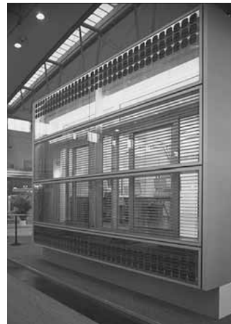
Fotos oben: Das 1:1-Modell eines Büroraums des IG-Metall-Hochhausentwurfs auf der Constructec 1996 zeigt die steuerbaren Glaslamellen mit integrierten Photovoltaikzellen; unten: Innenansicht.
