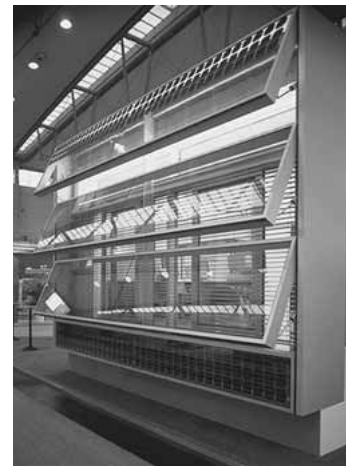
Fotos oben: Das 1:1-Modell eines Büroraums des IG-Metall-Hochhausentwurfs auf der Constructec 1996 zeigt die steuerbaren Glaslamellen mit integrierten Photovoltaikzellen; unten: Innenansicht.
