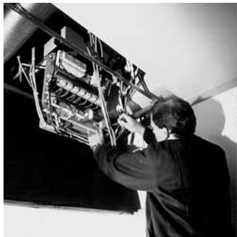
Oben: Montage der Einzelraumregelungseinrichtung der Büroräume der Commerzbank; rechts: Für die Be- und Entlüftung der Büros bei geschlossenen Fenstern wurde von Siemens eine spezielle Leuchte mit integrierter Lüftungstechnik entwickelt (Fotos: Siemens AG).
