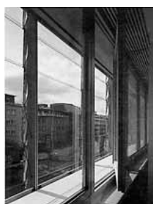
Oben: Schnitt durch die Fassade der Bayerischen Vereinsbank; darunter: Fassadenzwischenraum mit geöffneten und geschlossenen Lamellen (Fotos: Ralph Richter).
