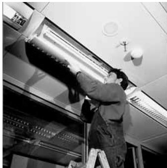
Oben: Montage der Einzelraumregelungseinrichtung der Büroräume der Commerzbank; rechts: Für die Be- und Entlüftung der Büros bei geschlossenen Fenstern wurde von Siemens eine spezielle Leuchte mit integrierter Lüftungstechnik entwickelt (Fotos: Siemens AG).
