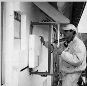
Oben: Drahtschnittrahmen zweifach kippbar; daneben konische Laibungen, Gehrungen; darunter: Universal-schleifgerät mit zwei gegenläufig drehenden Scheiben.
