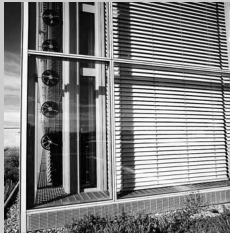
Gebäudeecke mit Lüftungsklappen im Sockelbereich, Axialgebläse für horizontale Luftströmung, Sonnenschutz aus Raffstore-Lamellenelementen zur Optimierung des Lichteinfalls.
