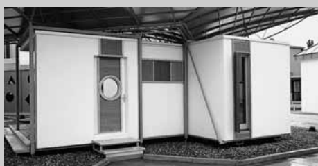
Mobilbaurucksack im Raster 3,00 x 1,50 m von Primärgerüst abgehängt.
