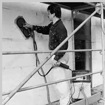
Oben: Drahtschnittrahmen zweifach kippbar; daneben konische Laibungen, Gehrungen; darunter: Universal-schleifgerät mit zwei gegenläufig drehenden Scheiben.
