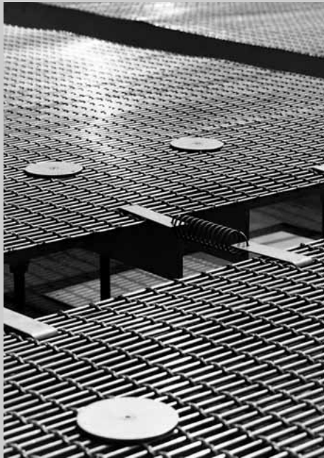
Rechts: Dachverkleidung der olympischen Radsporthalle in Berlin mit großmaschigen Strukturgittern; Architekt Dominique Perrault.
