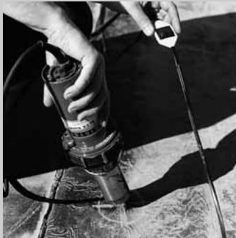
Oben: Einbringen der Sensoren für flächige Sensoranlage Progeo Smartex; darüber: Meßredundanz durch Überlagerung.
