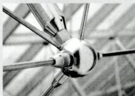
Oben: filigrane Seilverspannungen am Tokyo International Forum von TriPyramid (Arch.: Rafael Vinoly); darunter: Knotenpunkt einer seilverspannten Dachverglasung an der Harvard University
