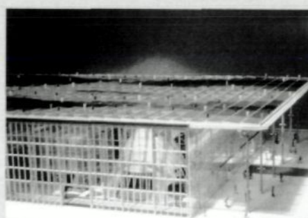
Modell des größten Solardachs der Welt: 9.500 m 2 Photovoltaik- module von Pilkington Solar, Köln für die Fort- bildungsakademie Herne (Arch.: Jourda/Perraudin)
