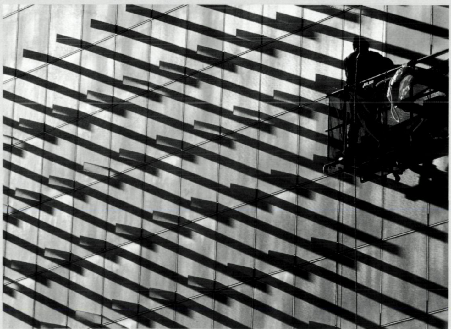
Refractive Glass Wall (1996). 30m lange und 15m hohe, gebogene Glaswand an der First Hawaiian Bank. Je fünf
