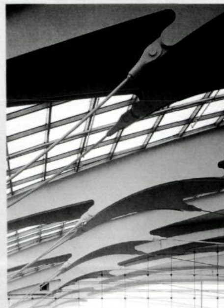
Kempinski Airport Hotel (Murphy/Jahn): Die 40 x 25 m Fassade besteht aus einem vorgespannten, ebenen Seilnetz, das von dem Bogenträger über
