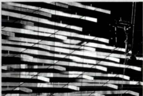
Dichroic Light Field (1995). Außenwand eines New Yorker Fitnessclubs aus laminierten Glasscheiben auf einer Stahlunterkonstruktion. Durch die diffuse Oberfläche werden die wechselnden Lichtstimmungen des Himmels reflektiert. 216 senkrecht stehende, dichroische, laminierte Glasschwerter, die jeweils komplementäre Hälften des Lichtspektrums durchlassen oder reflektieren, schaffen permanent wechselnde Farbfelder. Von Norden gesehen reicht das Spektrum von Blaugrün bis Indigo, aus südlicher Richtung von Gold bis Magenta.
