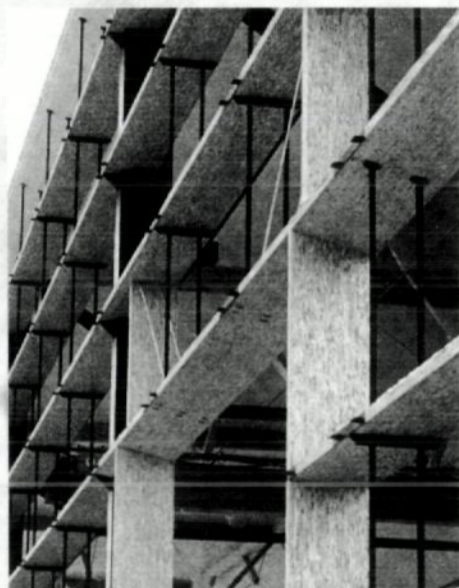
Konstruktiver Einsatz von Parallam in Kombination mit Stahlprofilen als Traggerüst einer großflächigen Glasfassade (Entwurf und Ausführung: Kaufmann Holzbauwerk)
