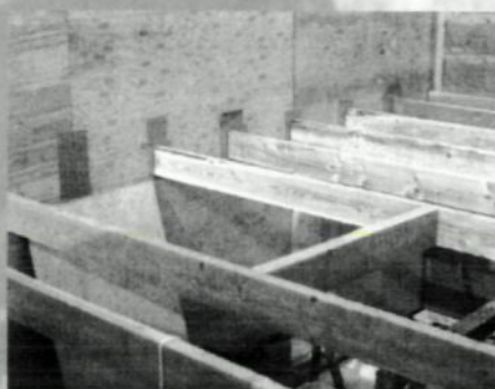
Oben und rechts: Modifizierter Holzrahmenbau beim LBS-Öko-Haus: An der durchgehenden, winddichten Beplankung der zweigeschossigen Rahmen werden die Deckenträger eingehängt.
