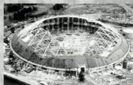
Oben und rechts: Montage von vorgefertigten Kuppel-elementen aus Kerto-Furnierschichtholz für die Sporthalle Oulu/Finnland mit 115 m Durchmesser
