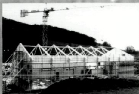
Außenwandelemente aus Holzblocktafeln bei einer Sporthalle in Hemmiken/Schweiz; rechts Fassadenschnitt: 3-geschossige Dickholzelemente als tragende Außenwandkonstruktion, gleichzeitiger Witterungsschutz durch aufgeleimte Kerto-Furnierschichtholzplatte
