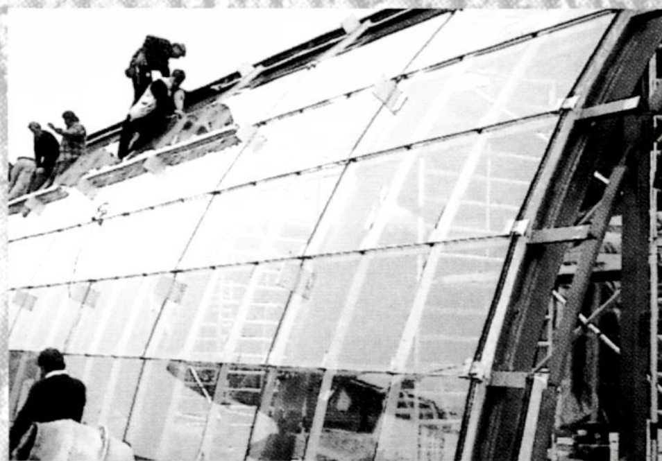
Tonnenförmige Holz-Glas-Fassaden am Schulungsgebäude des Öko-Zentrums Hamm (Architekten: HHS); links oben: System-schnitt Pfosten-Riegel-Fassade System Becker + Sohn
