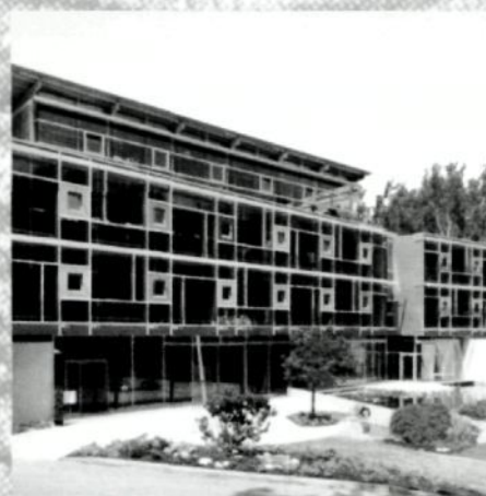
Holz-Glas-Konstruktion beim Bürohaus Sortimo. Die Glasscheiben werden mit Alu-Prebleisten auf die tragenden Pfosten und Riegel aus FSH aufgesetzt. Ein Teil der Glasfassade ist als hängende Konstruktion mit in den Glasstößen geführten Seilen ausgeführt; oben links: Vertikalschnitt der Aussteifungsrahmen mit Kippfenster; oben: Horizontaler Systemschnitt der Glasfassade
