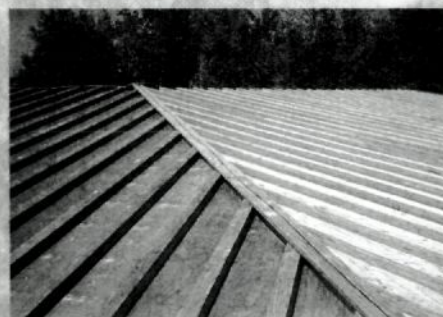
Oben: bis zu 10,50 m lange Merk-Rippenplatten als Zwei- bzw. Dreifeldträger mit oberflächenfertiger Untersicht (Mehrzweckhalle der Grundschule Aichach-Nord); links: Merk-Dachplatten
