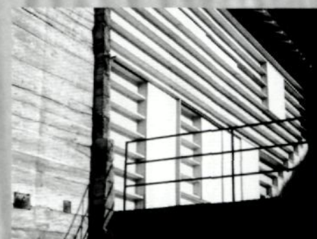
Oben links: Prinzipskizze des Lignatur-Systems: Vorgefertigte Module als Kasten- oder Flächenelemente für Decken, Dächer und Wände; links: Montage wärmedämmter Schalenelemente im Dachbereich; rechts: Horizontal eingesetzte Lignatur-Elemente in spezieller Ausbildung als Außenwand beim Haus Truog Gugalun von Peter Zumthor
