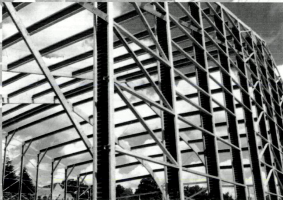
Oben: 11 m lange Pultdachsparren einer Gewerbehalle als Nail-Web-Träger; links: Wand- und Dachträger aus dem Nail-Web-System in der Anwendung beim Gewerbebau
