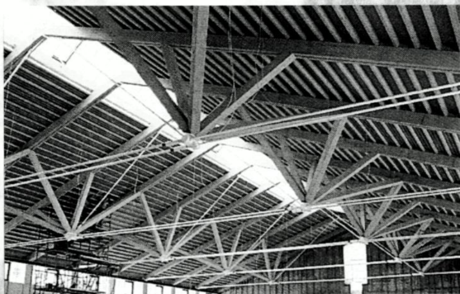
Oben: bis zu 10,50 m lange Merk-Rippenplatten als Zwei- bzw. Dreifeldträger mit oberflächenfertiger Untersicht (Mehrzweckhalle der Grundschule Aichach-Nord); links: Merk-Dachplatten
