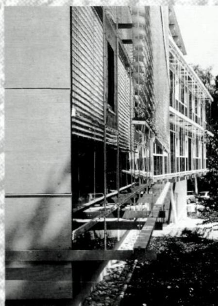
Holz-Glas-Konstruktion beim Bürohaus Sortimo. Die Glasscheiben werden mit Alu-Prebleisten auf die tragenden Pfosten und Riegel aus FSH aufgesetzt. Ein Teil der Glasfassade ist als hängende Konstruktion mit in den Glasstößen geführten Seilen ausgeführt; oben links: Vertikalschnitt der Aussteifungsrahmen mit Kippfenster; oben: Horizontaler Systemschnitt der Glasfassade
