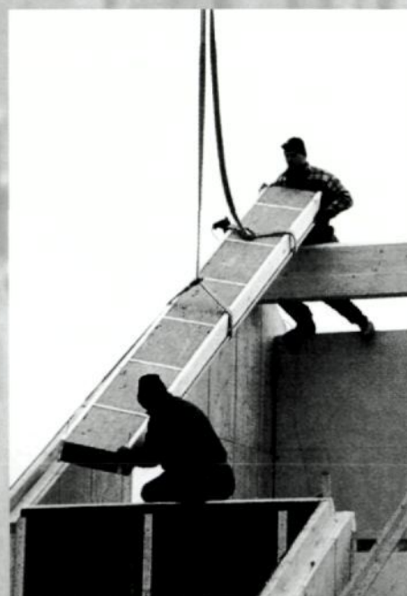
Oben links: Prinzipskizze des Lignatur-Systems: Vorgefertigte Module als Kasten- oder Flächenelemente für Decken, Dächer und Wände; links: Montage wärmedämmter Schalenelemente im Dachbereich; rechts: Horizontal eingesetzte Lignatur-Elemente in spezieller Ausbildung als Außenwand beim Haus Truog Gugalun von Peter Zumthor
