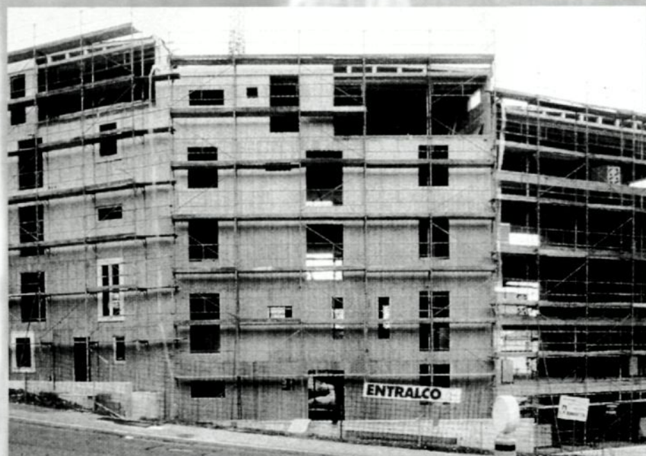
Oben: Tragende Wand- und Deckenelemente aus Brettstapeln bei einer 5-geschossigen Wohnanlage in Gilamont-Vevey/Genfer See (Architekten Bellmann/Pedrolini); rechts: Brettstapелеlemente als fertige Deckenunter-sicht
