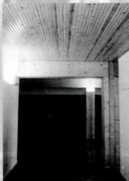
Oben: Tragende Wand- und Deckenelemente aus Brettstapeln bei einer 5-geschossigen Wohnanlage in Gilamont-Vevey/Genfer See (Architekten Bellmann/Pedrolini); rechts: Brettstapелеlemente als fertige Deckenunter-sicht
