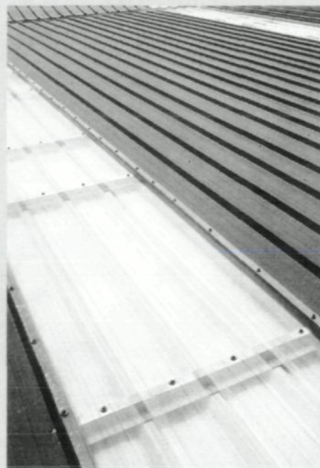
Oben: Dachverglasung aus Lexan LCS/T Trapezplatten; rechts oben: Fensterprofil aus Noryl GTX; darunter: Seilnetzvorhang mit Lexan-
