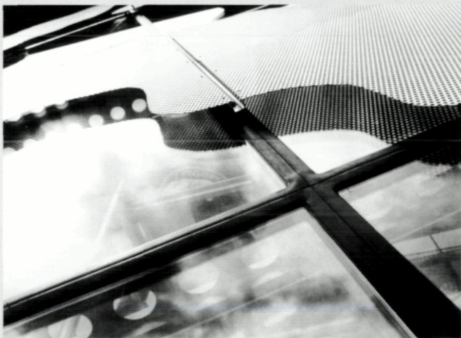
Oben: Eingangsbereich des LEEp-Zentrums; unten: Klimawand aus Lexan Margard mit Dichtungen aus GE Siliconen. Das Lochblech dient als Abschattung gegen Überhitzung.
