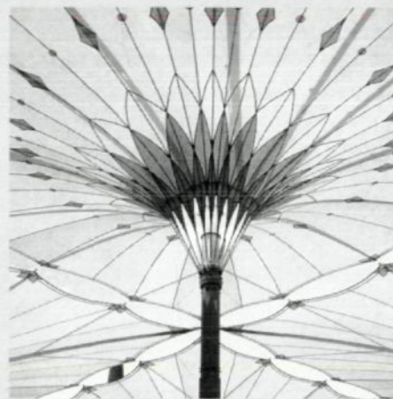
Unten: Seilnetzdach am Dschungelzelt im Tierpark Hellabrunn
