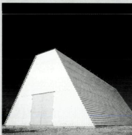
Metallfreie Spezialbauten aus Verbundwerkstoffen (Hersteller: Fiberline Composites A/S, Kolding). Tragende Profile, Verbindungsbolzen und Außenhaut bestehen aus korrosionsfreiem, gut isolierendem GFK. Stahlbauten ähnlicher Bauweise haben im Durchschnitt das doppelte Gewicht.
