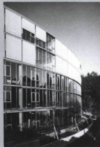
Geilinger Unithermfassade am Büro- und Gewerbehause Zolllikofen in Bern von Atelier 5.
