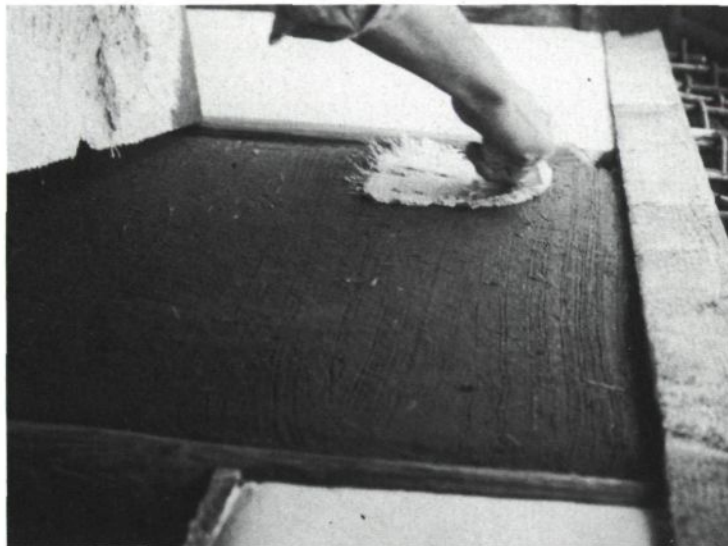
Lehmwand mit Ausgleichsschicht in Lehm, geriffelt für den Auftrag des Kalkputzes (A. Kusumi)
