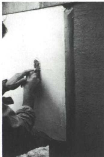
Der Kalkputz wird unter Druck geglättet.
