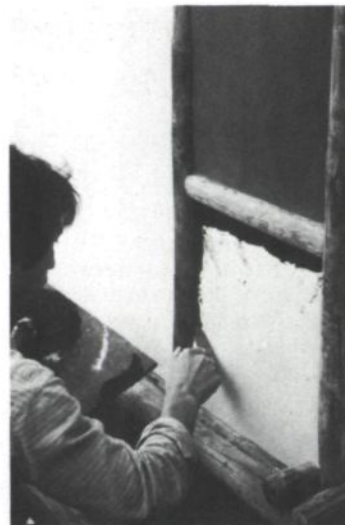
Auftragen der 1. Farbschicht auf den Kalk-Unterputz. Die Rohwand darunter ist aus Lehm (A. Kusumi)
