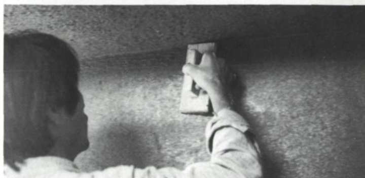
Lehmputz an Wand und Decke. Mit einer Holzkelle wird der relativ flüssige Putz leicht angezogen (A. Kusumi)
