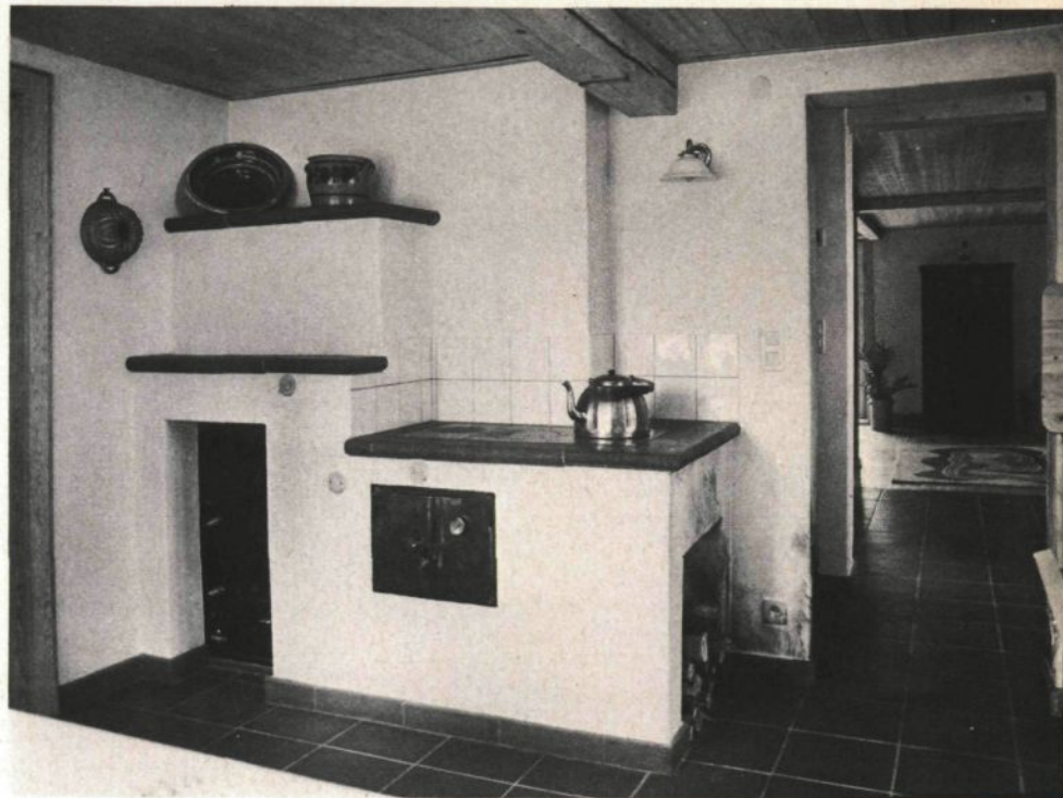
Küchenofen: Heizung, Koch- und Backherd, Warmwasserbereiter
