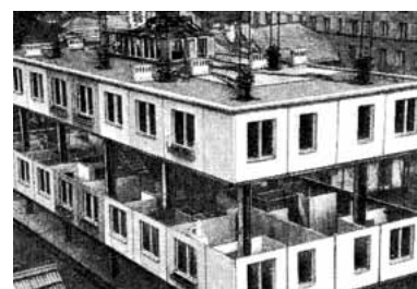
oben: Neue, seit Ende der 1950er Jahre erprobte Bauweise, bei der komplette Etagen mit Hilfe hydraulischer Mechanismen aufeinander gesetzt werden. Die Last ruht auf einem Stahlträgergerüst, weshalb die Wände aus leichten Materialien konstruiert werden können.
