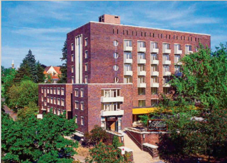
Das 8-geschossige Hochhaus wurde um ein Geschoss aufgestockt, die zwei unterschiedlich langen, je nach Verlauf des stark abfallenden Geländes 3- bis 4-geschossigen Riegel verlängert. 137 vorwiegend 1-Zimmer Apartments wurden zu 89 Atriumwohnungen,
