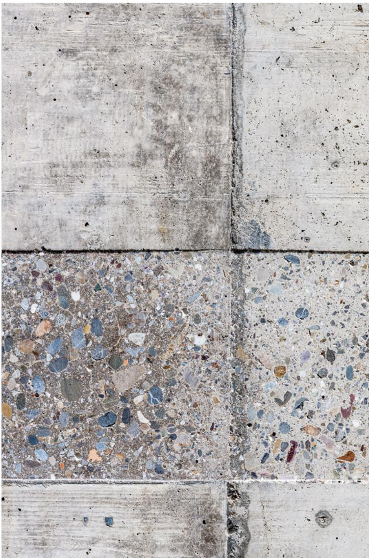
Detail Musterwand, geschliffene Oberfläche.
