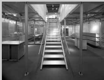
Doppelstocksystem Pila aus Zusammenarbeit mit Schlaich Bergermann und Partner. Überarbeitete Knoten und Profile sorgen für ein filigraneres Erscheinungsbild.
