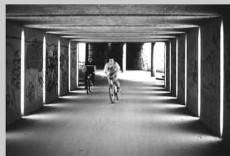
**Am Auer Mühlbach:** Für eine Durchfahrt des Radweges ist die Ohlmüllerbrücke über den Mühlbach zu niedrig. Daher wurde der Weg in einer Betonwanne abgesenkt. Einmal am tiefsten Punkt, befindet sich ein Radfahrer mit den Schultern gerade etwas höher als die bis auf Wasserniveau abgesenkte Stützwand, sieht und riecht im Halbdunkel das frische Wasser aus unmittelbarer Nähe, um dann aus eigenem Schwung wieder ins Helle und in eine normale Position zum Wasser zu gelangen.
